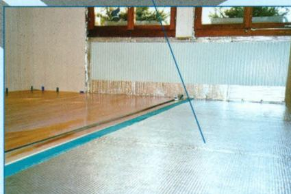
Dämmung unter Teppich-Laminatboden
